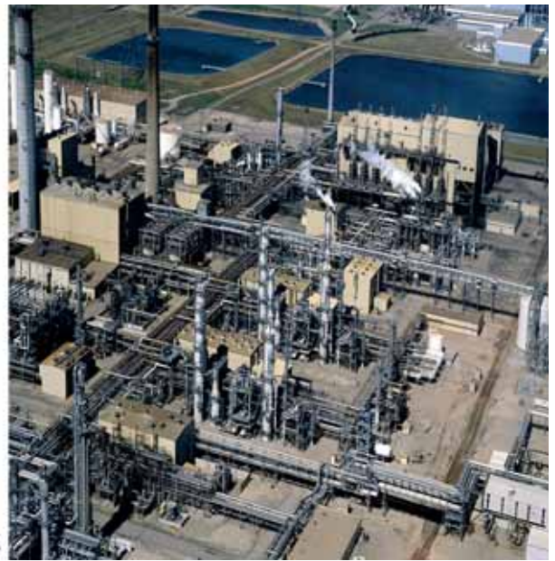
Рисунок ТР.4. (a) Улавливание CO 2 после сжигания топлива на установке в Малайзии. В этой установке применяется процесс химической абсорбции для отделения 0,2 МтCO 2 в год от потока дымового газа энергоустановки для производства мочевины, работающей на сжигании газа (с разрешения «Мицубиши хэви индастриз»); (b) улавливание CO 2 до сжигания на установке газификации угля в Северной Дакоте, США. В этой установке применяется процесс на основе физического растворителя для отделения 3,3 МтCO 2 в год из газового потока для производства синтетического природного газа. Часть захваченного CO 2 используется для проекта ПИН в Канаде.
